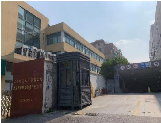
南侧—上海灯泡三厂有限公司
